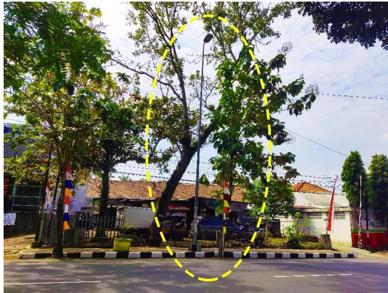
Gambar 1. Kondisi Lampu Penerangan Jalan yang Terhalang Pepohonan
