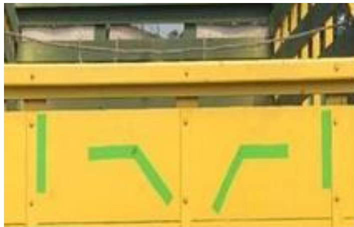
Gambar 2. Pemasangan Alat Pemantul Cahaya Yang Tidak Sesuai Berkenaan dengan pemasangan alat pemantul cahaya, peraturan telah
