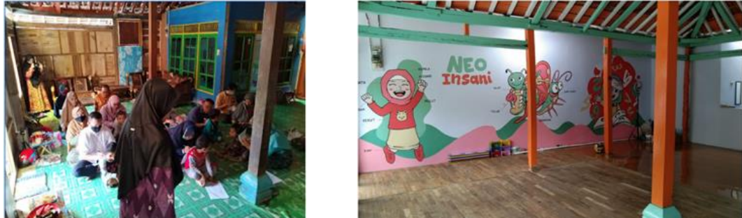
Gambar 3. Renovasi Gedung Sekolah
